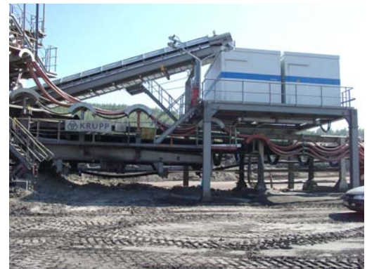
Probentransportband, Aufbereitungs-Container und Analysecontainer
